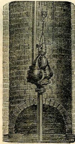
Pulsomètre suspendu dans un puits ordinaire.
